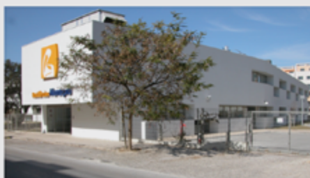
Residência Montepio Montijo
