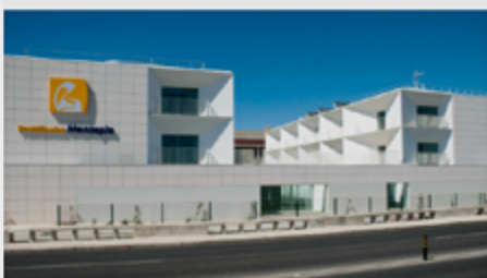
Residência Montepio Parede I e II (Cascais)
